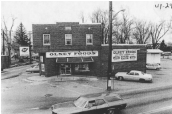
Old D.G.S. Grocery Store, SE corner
